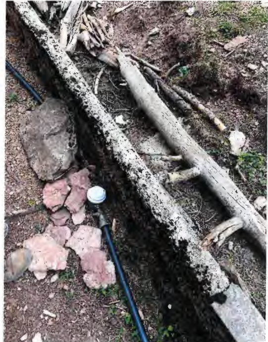
Figure 2 : Compteur mis en place par la REAAM pour contrôler les débits prélevés
